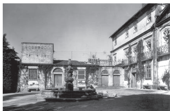
Figura 5 – Vista exterior da Cozinha, que revela a perpendicularidade ao corpo do edifício, destacando-se naquela a chaminé que se alça no topo esquerdo. Fotografia histórica que ilustra a área tal como existia cerca de 1965.
