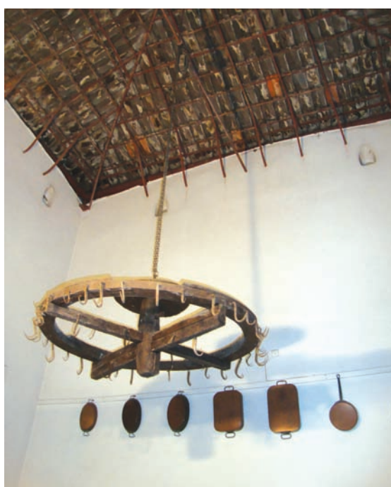
Figura 9 – Roda no interior da majestosa chaminé. A imagem ilustra os orifícios localizados a grande altura do lado interior, que, associados ao sistema de telha vã, promoviam o evitamento do fumo. A finalizar, observe-se parte da tacharia de bronze suspensa das paredes, como forma funcional e decorativa de acondicionar a mesma.
