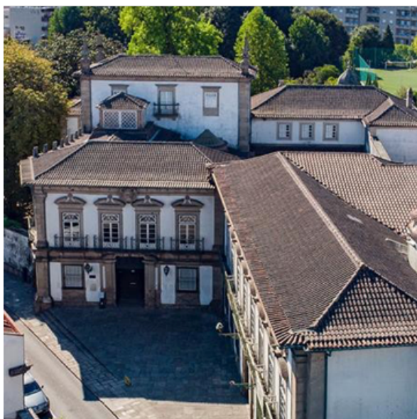
Figura 2 Museu dos Biscainhos, fachada nascente.
